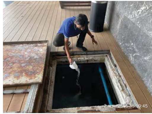
เจ้าหน้าที่ทำการเติมสารเคมีฆ่าเชื้อโรคสระว่ายน้ำ
