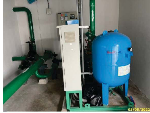
Booster Pump ชั้นคาตฟ้า
